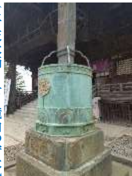
(上・天水桶 下・境内の貯水設備)
